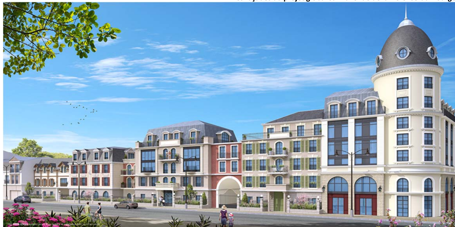
Les façades du projet global sur l'avenue de la Défense-du-Bourget
