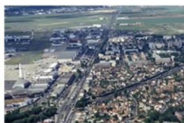
L'ex-RN2/17 et l'autoroute A1
