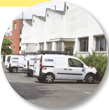
Le centre technique municipal sera transféré et modernisé.
