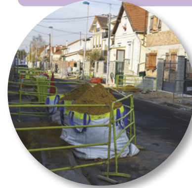
Rénovation de la rue Maxime-Gorki
