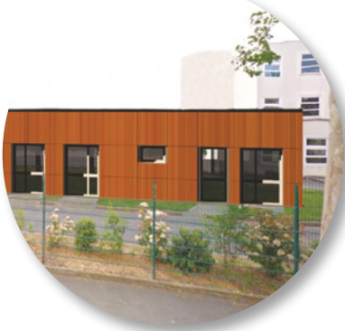
Le nouveau restaurant scolaire Wallon-Lurçat
