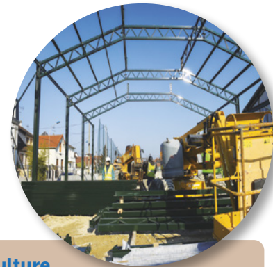
Construction du boulodrome couvert Francis-Bort
